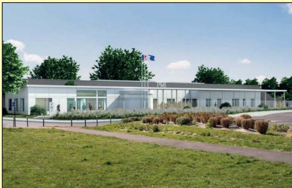
Le Département a porté la réalisation d'un Data Center et d'une PMI à Valenton.
