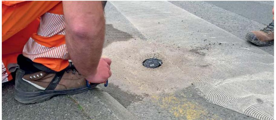
*Vigil-ice est un capteur placé dans la chaussée, qui détecte la température de la route, son taux d'humidité, les risques de givre et d'aqua-planning, etc. Ces données sont communiquées par wifi aux stations météo des services routiers et aux radars automatiques. Messages d'alerte à destination des usagers et adaptation des vitesses contrôlées peuvent ainsi être déclenchés.*
