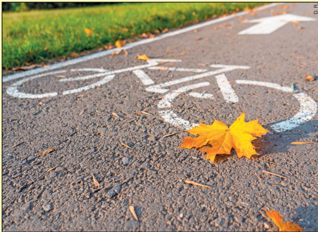
Ces trois dernières années, plus de 10 millions d'euros ont permis la création de nouveaux aménagements cyclables (16 km réalisés).
