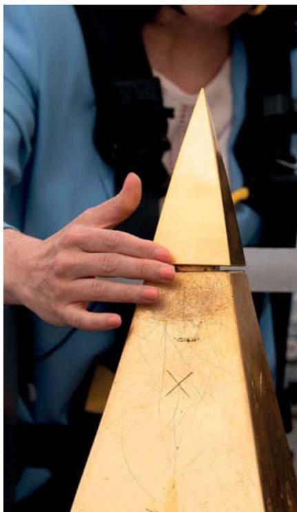
Le pyramidion en place était resté inachevé à son sommet pour des raisons techniques liées au déroulement contraint du chantier. Il fut terminé par un pas de vis permettant le guidage pour la pose ultérieure d'une pointe. Ce sommet inachevé laissait incomplète la cohérence esthétique du pyramidion et permettait à des volatiles de s'y poser et de le dégrader.
