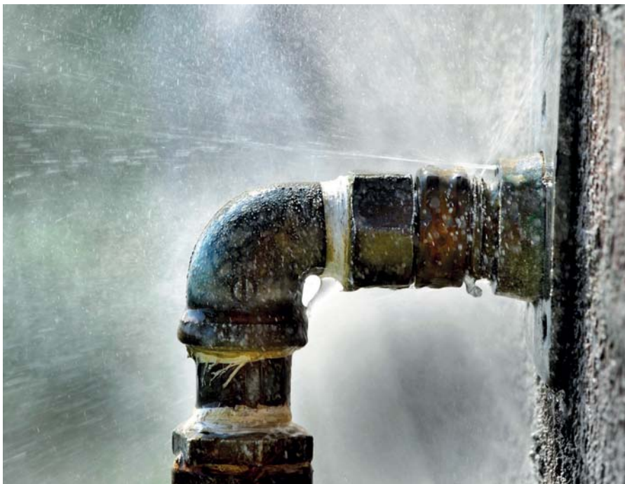
Réduire les fuites et sécuriser l'approvisionnement en eau potable.
