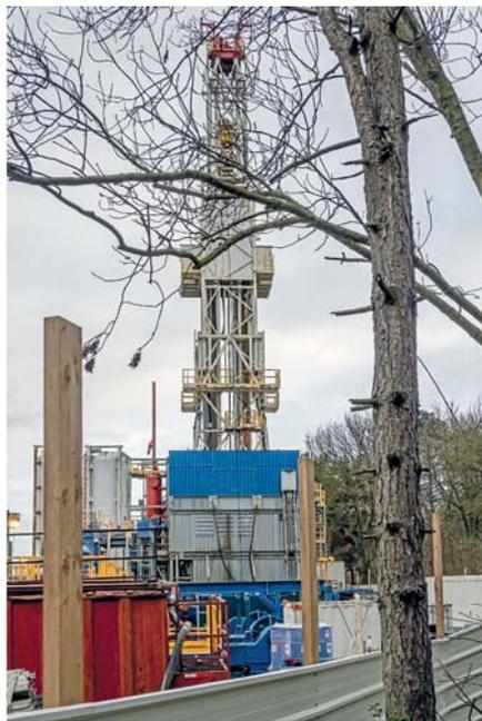
*La géothermie profonde exploite des nappes d'eau souterraines de températures comprises entre 30 °C et 200 °C, à des profondeurs généralement comprises entre 500 et 3 000 mètres. Ici, un puits en cours de forage à Bobigny.*
