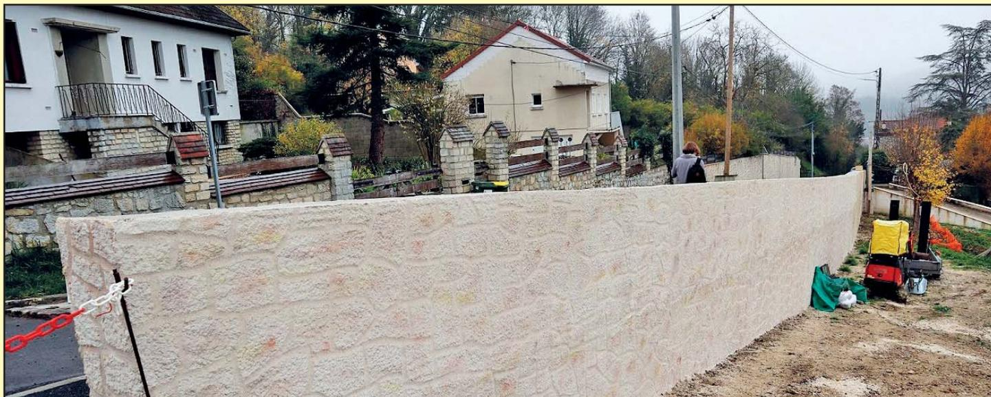
Ces travaux de sécurisation et de renforcement ont concerné la rénovation d'un mur de soutènement sur la route de Montgardé.
