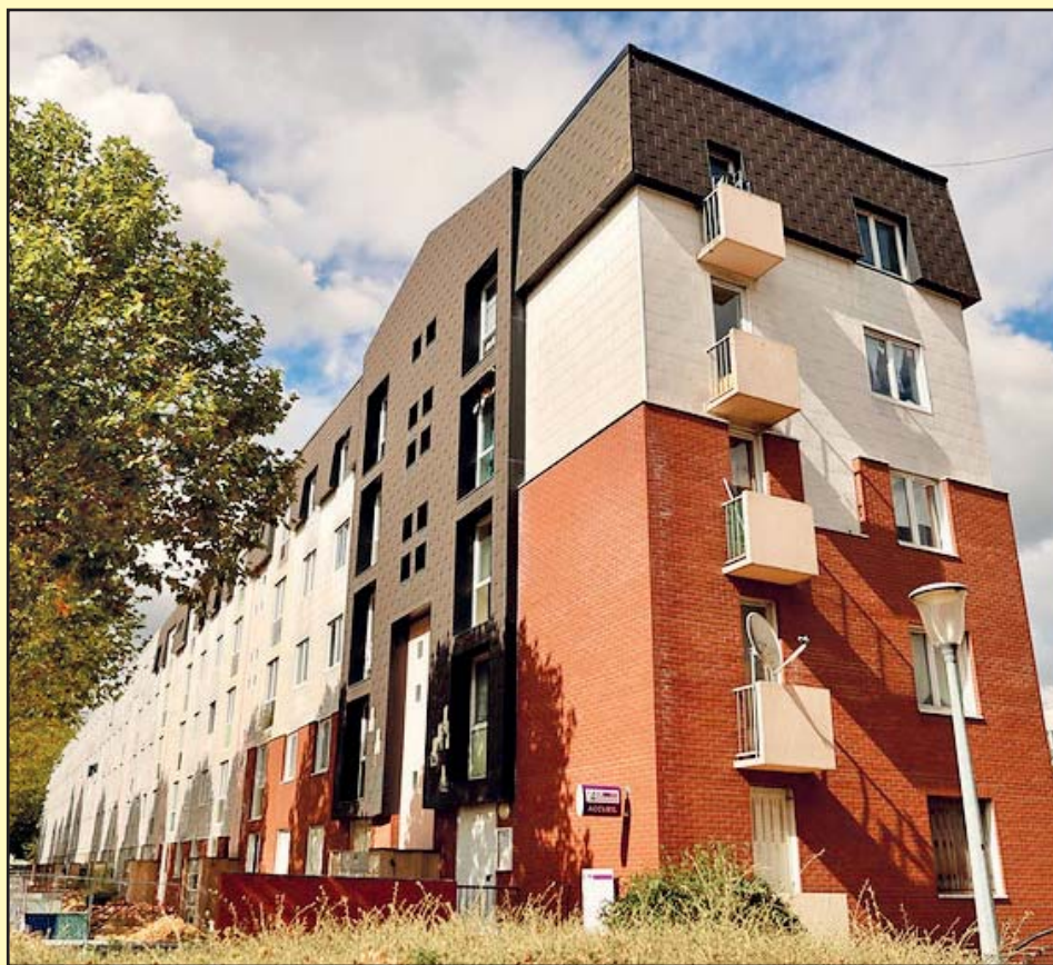
Sur ces 3 projets situés à Poissy, Élanecourt et Saint-Cyr-l'École, le soutien départemental permet de maintenir 25 opérations d'habitat, d'équipements publics et d'espaces publics.
