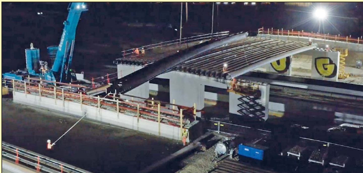
Pose des premières poutrelles du franchissement de la RN118.
