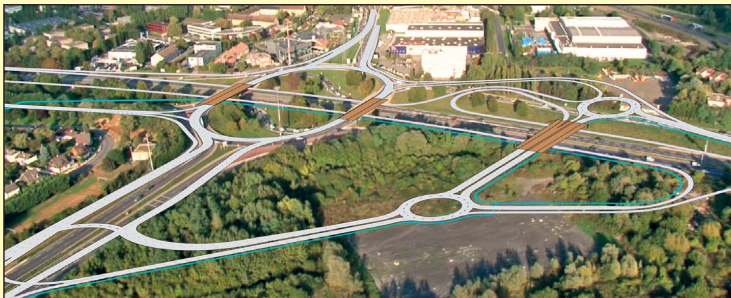
Un nouvel échangeur exclusivement réservé aux dessertes locales va sortir de terre à côté du Ring des Ulis.
