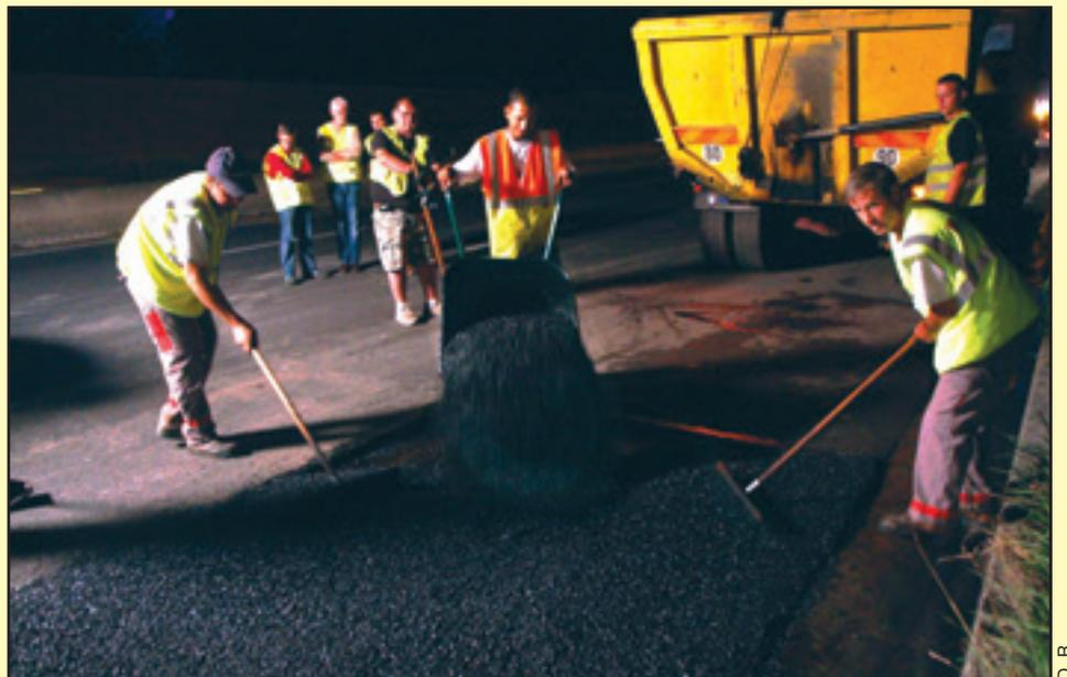
Cette technique permet de réutiliser des matériaux pour reconstituer la couche supérieure de la route. Elle évite une part importante de circulation d'engins de chantiers et donc de gaz à effets de serre.
