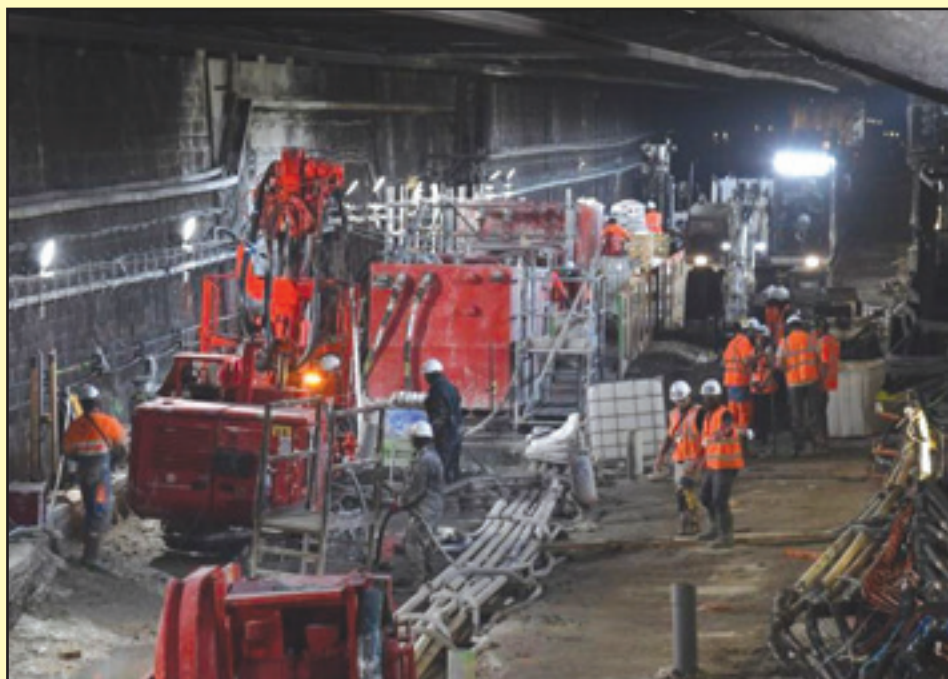
Depuis le mois de juin et jusqu'à la fin du mois d'août, 5 lignes de RER, 4 lignes de métro et 5 lignes de tramway connaissent des travaux nécessitant des interruptions temporaires de circulation.
