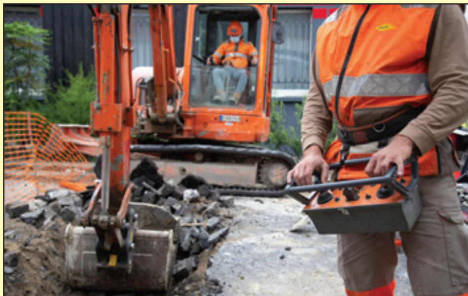
Remplacement de 80 mètres de la conduite principale d'assainissement.
