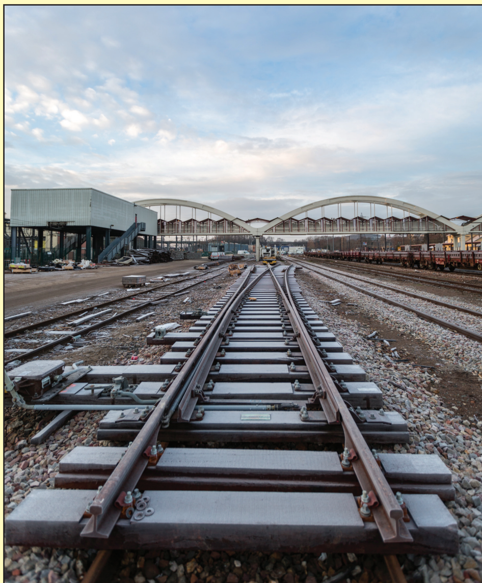
La pose des rails est réalisée sur des traverses bétonnées, solution retenue pour sa robustesse et la longévité qu'elle permet.
