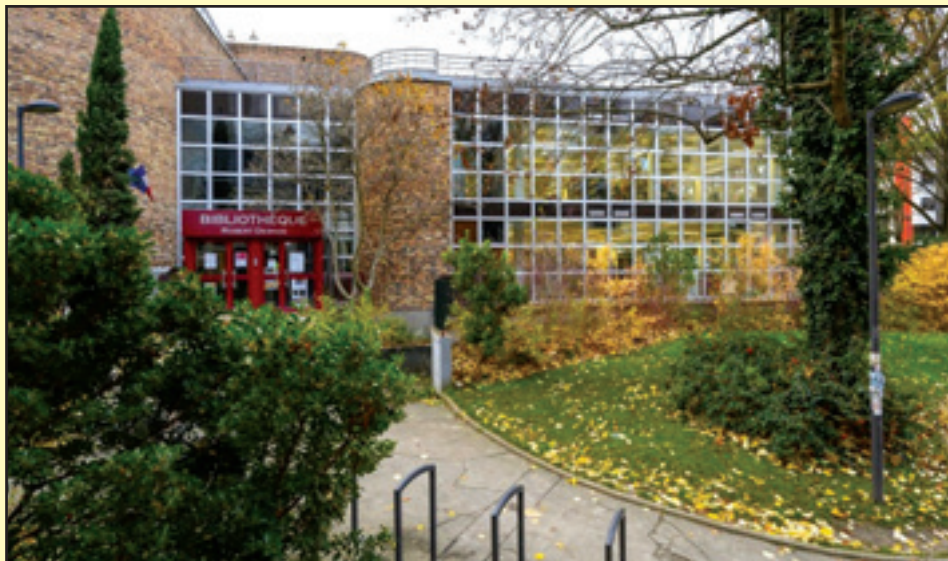
Une fois ces travaux terminés, les habitants pourront profiter d'une bibliothèque plus moderne, plus écologique, plus grande et complètement rénovée.
