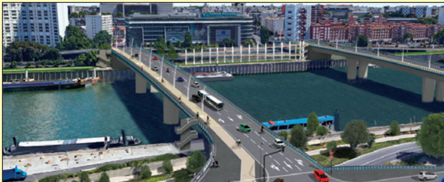
Les travaux sur les ponts Nelson Mandela vont en faire un carrefour cyclable d'importance pour le nord du Val-de-Marne.
