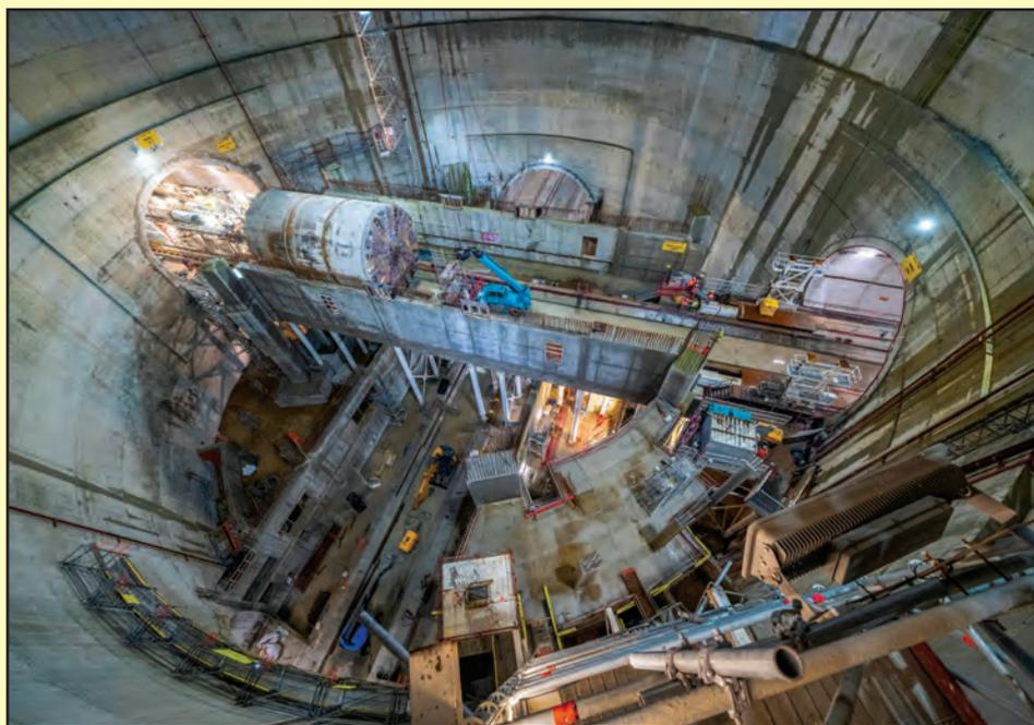
Une prouesse technique sans précédent avec le croisement quasi simultané de deux tunneliers de la ligne 14 sud et de la ligne 15 Sud dans un puits de 50 mètres de profondeur.
