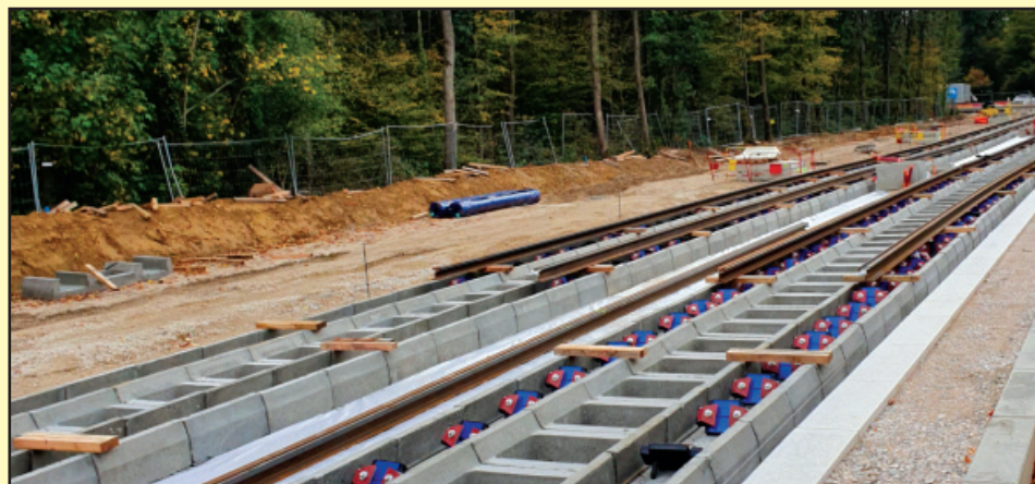
8 500 m 3 de béton et 700 tonnes de rails sur la chaussée aménagée.
