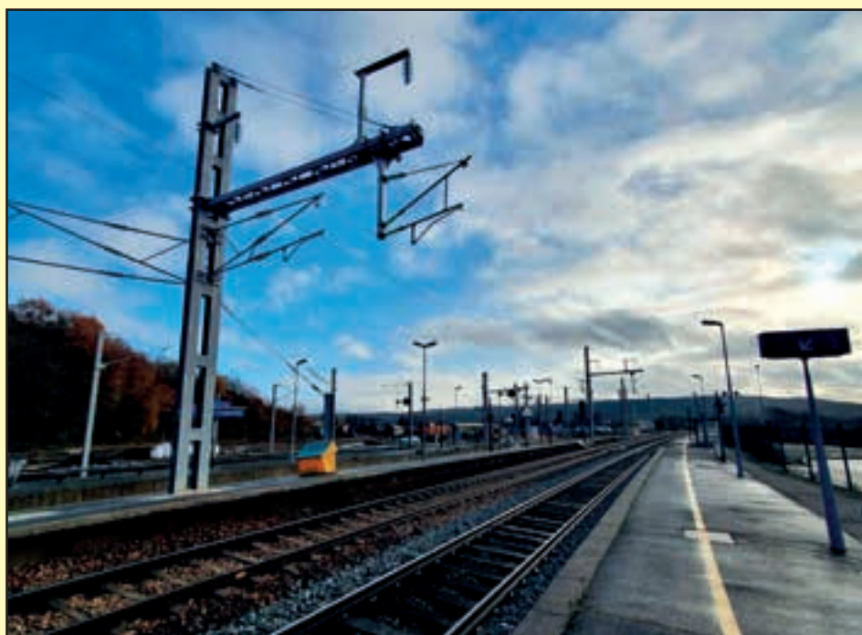
Les travaux d'électrification de la ligne P ont débuté début 2019. Les premiers kilomètres de caténaires sont déjà installés.
