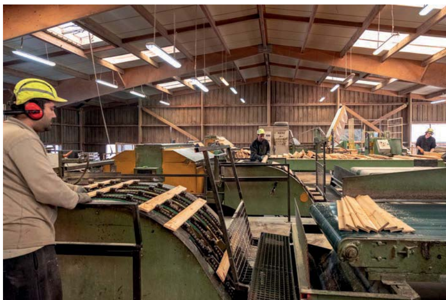
La scierie Migeon du groupe Archimbaud : une nouvelle chaudière permettra d'éviter les émissions de 3 500 tonnes de CO 2 par an.
