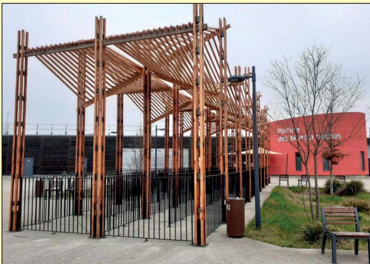
◀ Structure d'ombrage avec brumisateur créée sur le parvis de la piscine des Murs à pêche à Montreuil.
