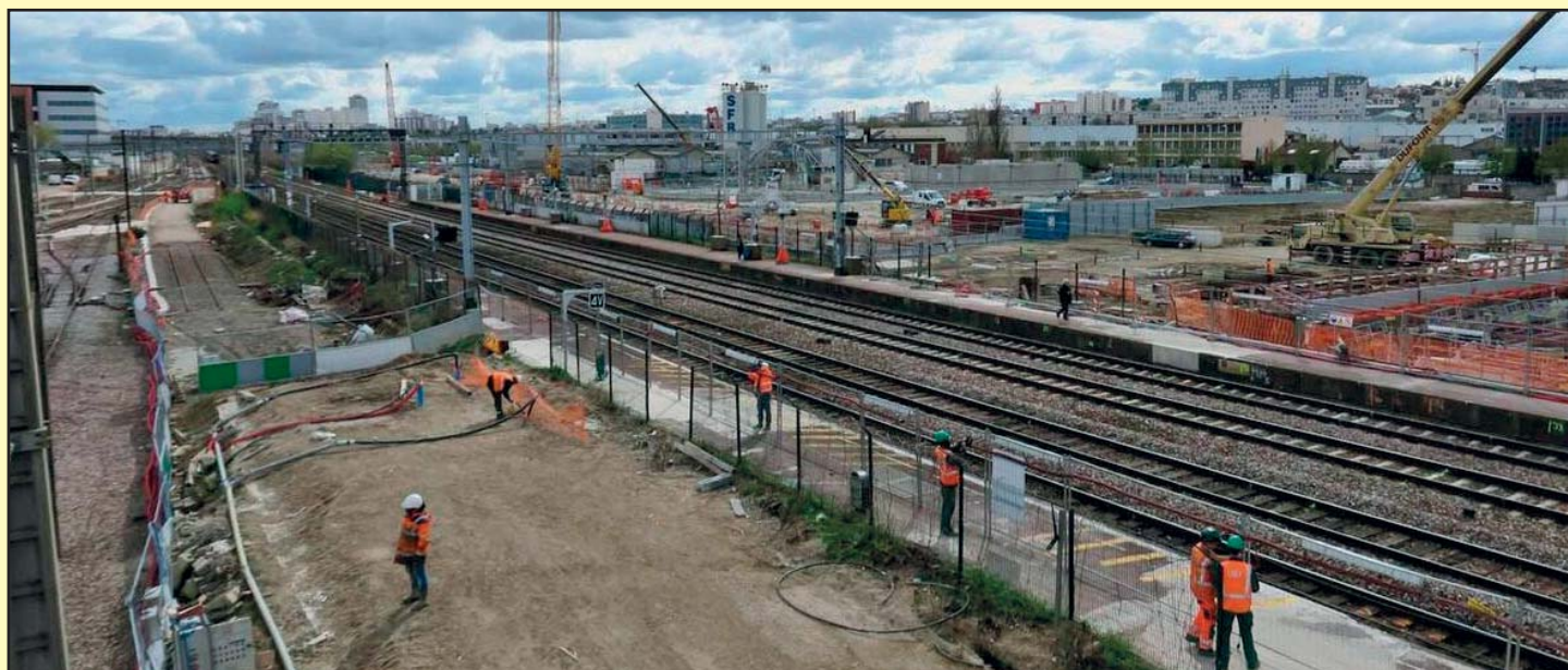
Le raccordement des cinq ouvrages de service au tunnel de la ligne 15 Sud poursuit son avancée.
