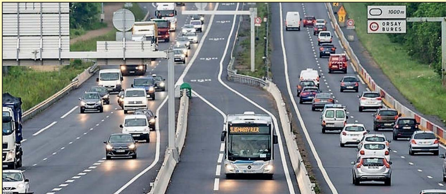
Développer un réseau routier d'intérêt régional en Essonne pour améliorer la fluidité des déplacements et la sécurité des usagers de la route.
