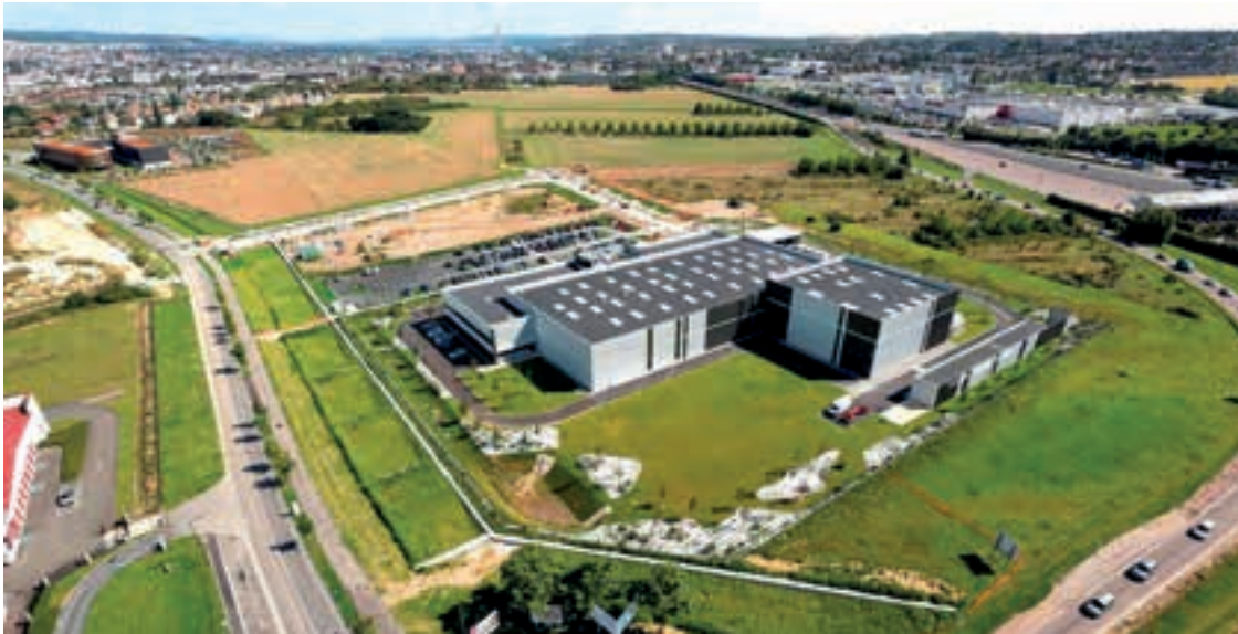
33 sites logistiques « clés en main » pouvant recevoir des activités industrielles ou logistiques sont immédiatement disponibles.
