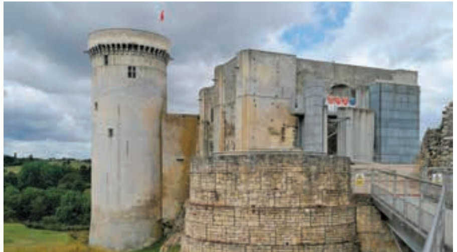
Les lieux de culture, de création et de patrimoine ont été tout particulièrement touchés par les mesures de fermeture administrative et de distanciation sociale. Ici, le château Guillaume à Falaise, en Normandie.
