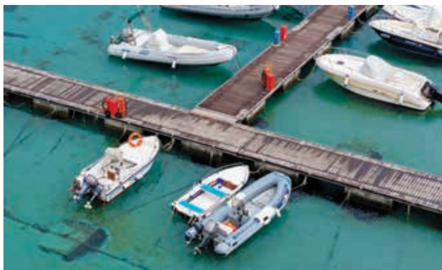
50 M€ à destination de 270 structures, réparties en parcs de stationnement et en infrastructures portuaires ou aéroportuaires. Ici, le port de plaisance Charles Ornano à Ajaccio.
