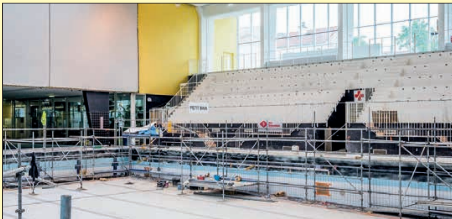
Travaux de rénovation du stade nautique Maurice Thorez en 2018.
